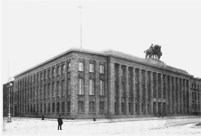
13. Архитектурный проект здания посольства Германской империи в Санкт-Петербурге /Architectural project of German Empire Embassy in St. Petersburg
